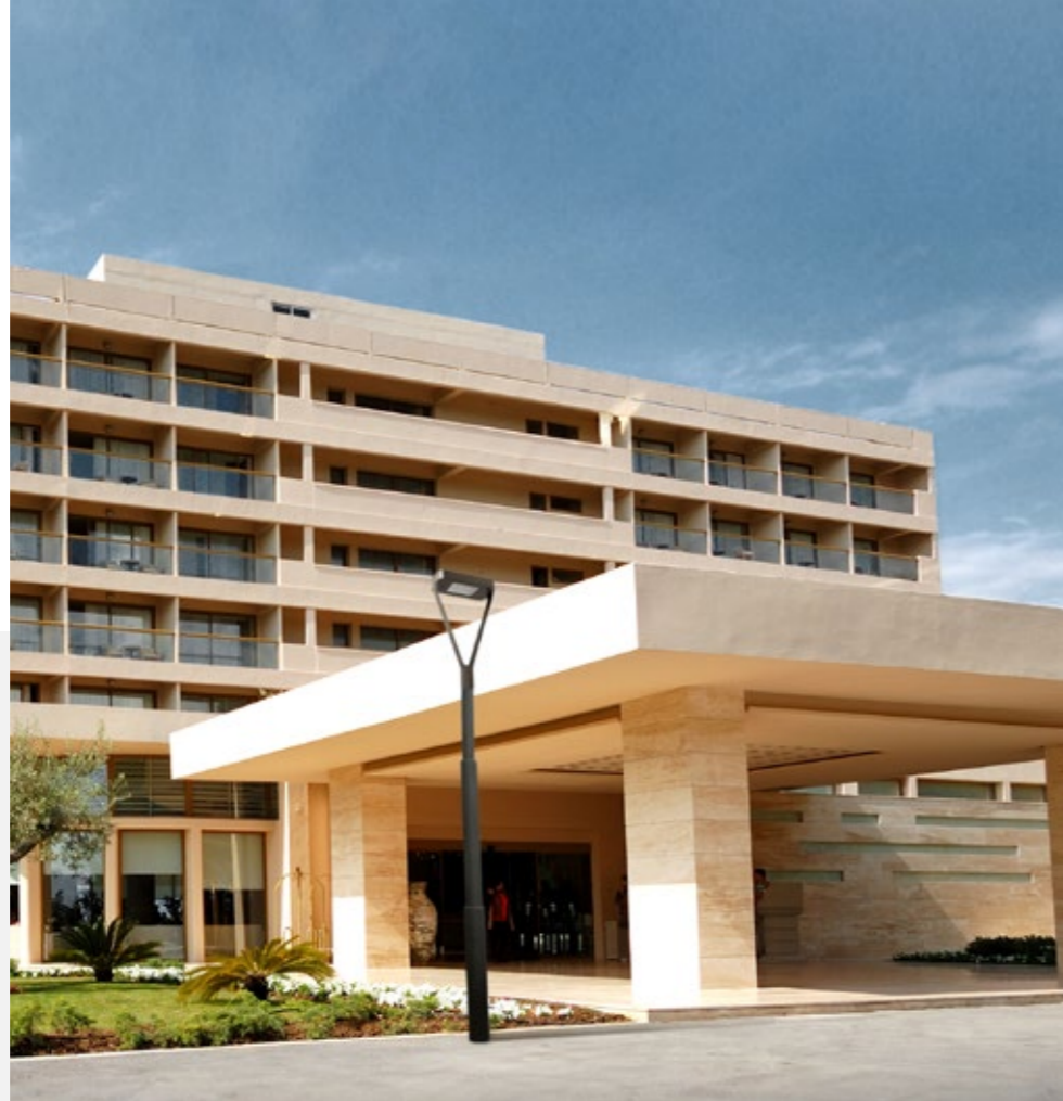
Hospitales, hoteles, centros comerciales, oficinas, ...
